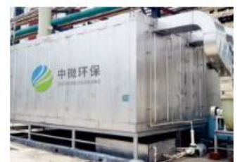
岳陽市國發精細化工廢氣處理工程
